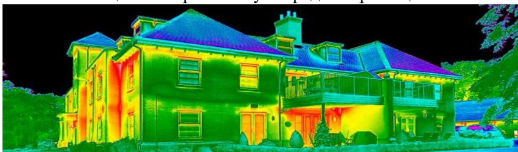
Рис 1. Приклад тепловізійного аналізу фасаду будівлі [2]
